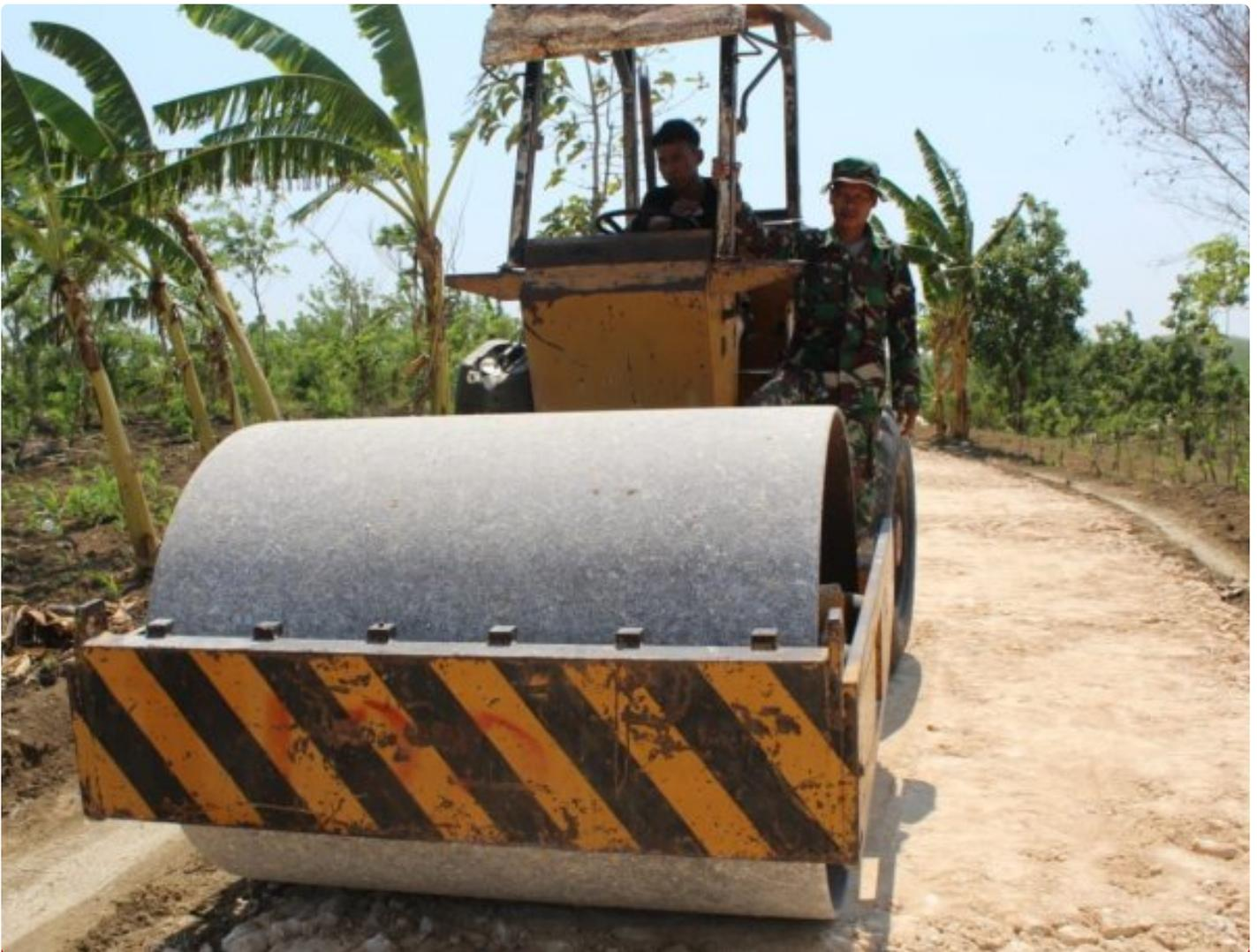
Foto: Satgas TNI Manunggal Membangun Desa (TMMD) ke-122 Kodim 0721/Blora mengerahkan alat berat untuk mempercepat pemadatan jalan makadam di Desa Sidomulyo, Minggu (27/10/2024).
